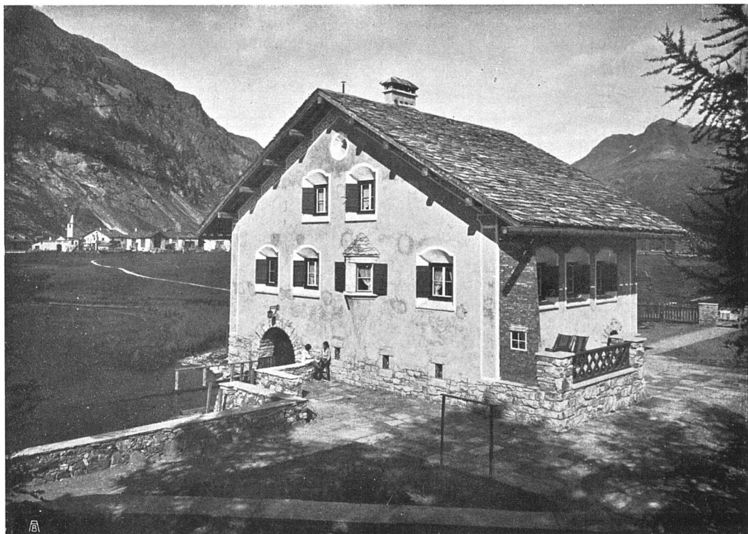
Maurer-Arbeiten und Bedachung mit Fexerplatten: H. Kuhn, Baugeschäft Sils; Granitarbeiten: A. Conrad, Granitwerke in Andeer; Glaserarbeiten: Müllers Söhne, mech. Bauglaserei Glarus; Wand- und Bodenbelag: A. W. Graf, Winterthur
