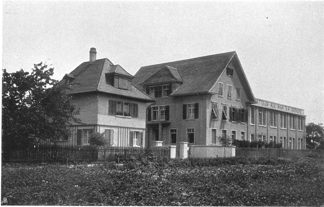
Oben: AGA A.-G., Pratteln, Ansicht gegen die Bahn, links Werkmeisterhaus, rechts Bureau und Werkstattgebäude Unten: Westrum & Co., Pratteln. Bureau u. Lagergebäude. Archit.: Widmer, Erlacher & Calini, Basel. Ausführung: Gebr. Spaini, Gebr. Häring, Pratteln; C. Gutknecht, Bildhauer, Basel; Jeuch, Huber & Co., Bodenbeläge, Basel; Tapetenlieferung für AGA und Westrum: W. Wirz-Wirz A.-G., Basel
