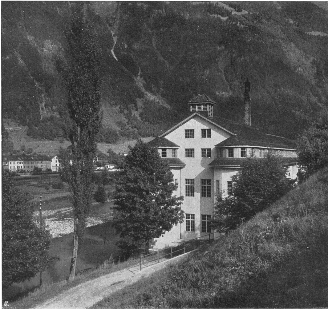
Fabrikneubau Hohlenstein Glarus. Architekt J. R. Streiff †. Steinlieferung: W. Wenk, Schmerikon; Erd- und Maurerarbeiten: Stüssy-Aebli, Glarus; Schreinerarbeit: Zweifel & Cie., Glarus
