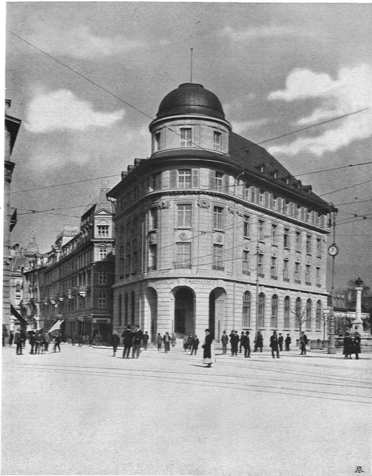
Bankgebäude Biel des Schweiz. Bankvereins, Ansicht von Südwesten Zentralplatz Architekten Saager & Frey, Biel; Bauunternehmung G. Hirt & Söhne, Biel; Bildhauerarbeiten J. Probst, Bildhauer, Basel
