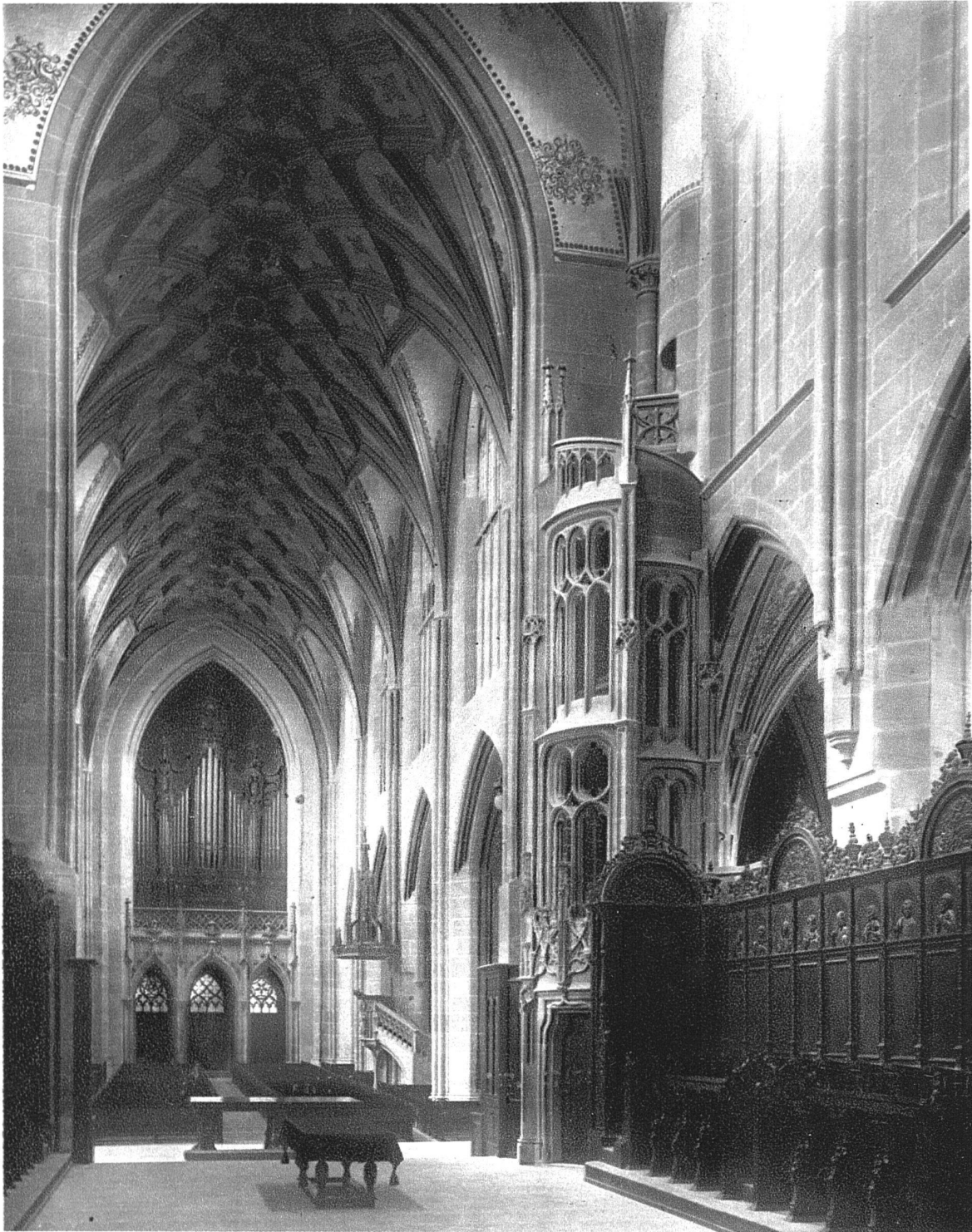
DAMPF-LUFTHEIZUNG BESONDERER BAUART FÜR KIRCHEN, AUSGEFÜHRT IM MÜNSTER BERN VON GEBRÜDER SULZER, AKTIENGESELLSCHAFT, WINTERTHUR
