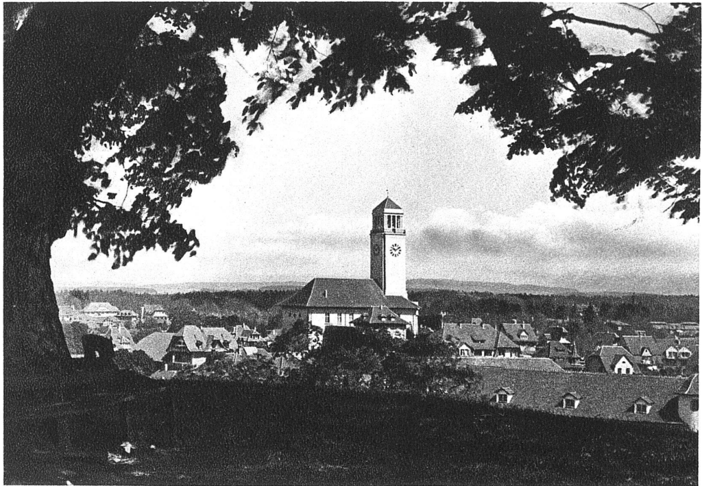
ABB. 3. GESAMTANSICHT VON SÜDEN
