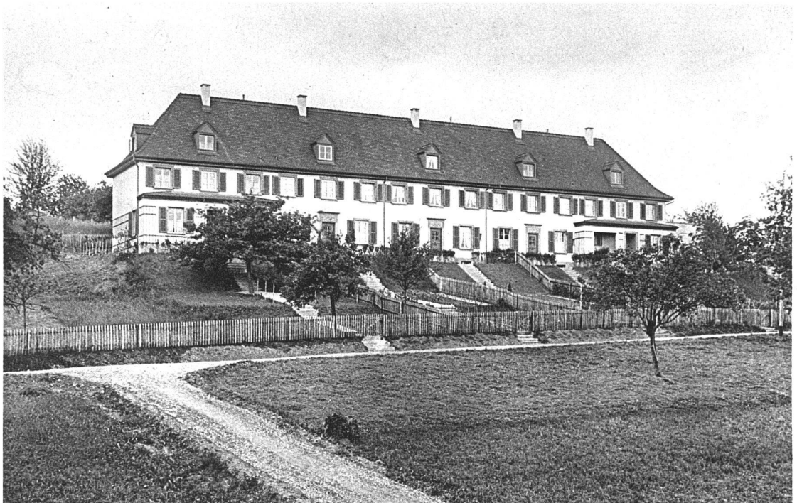
ABB. 14 HANS VON DER MÜHLL UND PAUL OBERRAUCH, ARCHITEKTEN, BASEL EINFAMILIENHÄUSER AM MULTENWEG BEI BASEL GESAMTANSICHT
