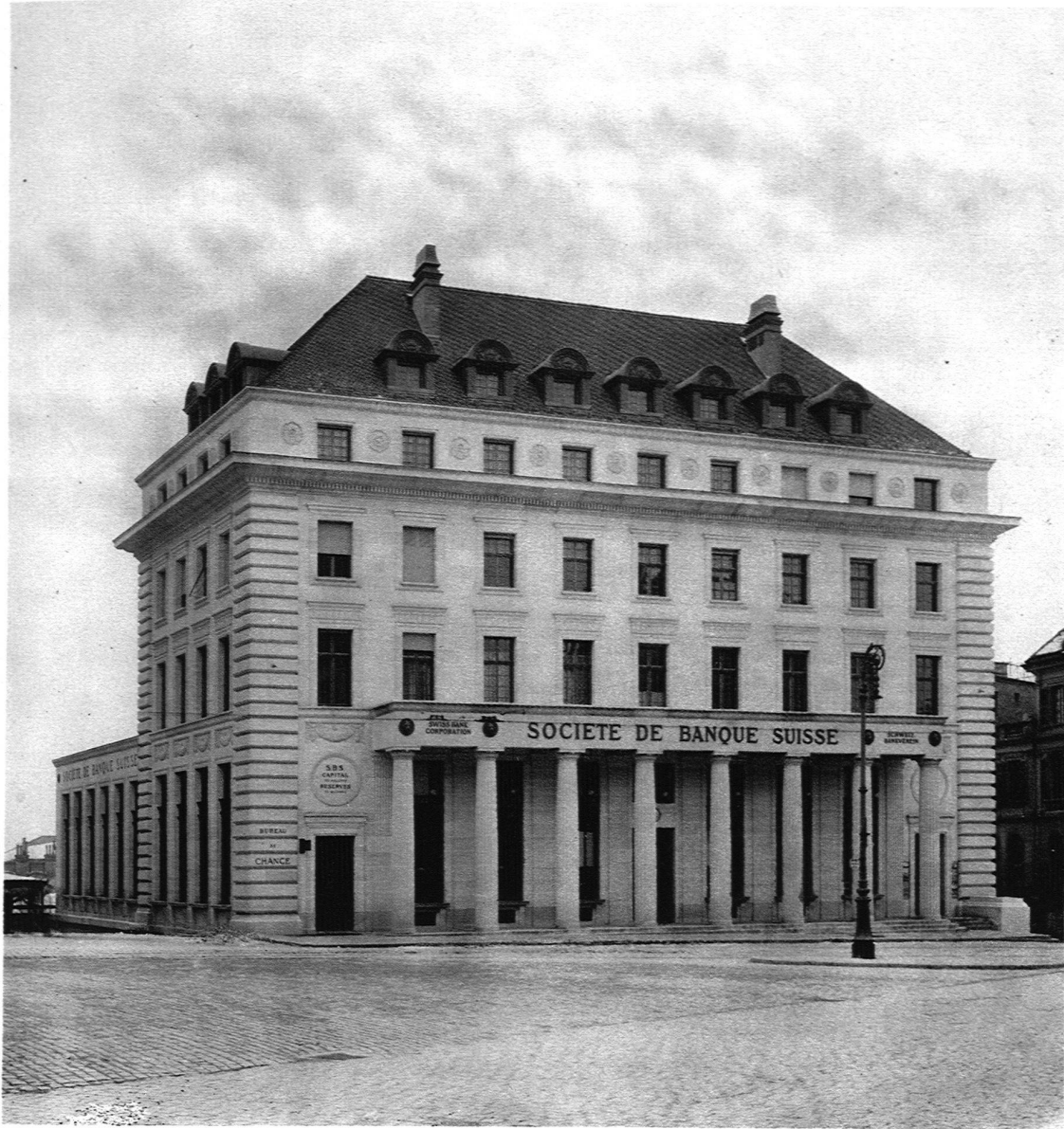
FIG. 16 SOCIÉTÉ DE BANQUE SUISSE, LAUSANNE ARCHITECTES : SCHNELL, THÉVENAZ F. A. S. ET BONNARD FAÇADE PRINCIPALE Phot. de Jongh
