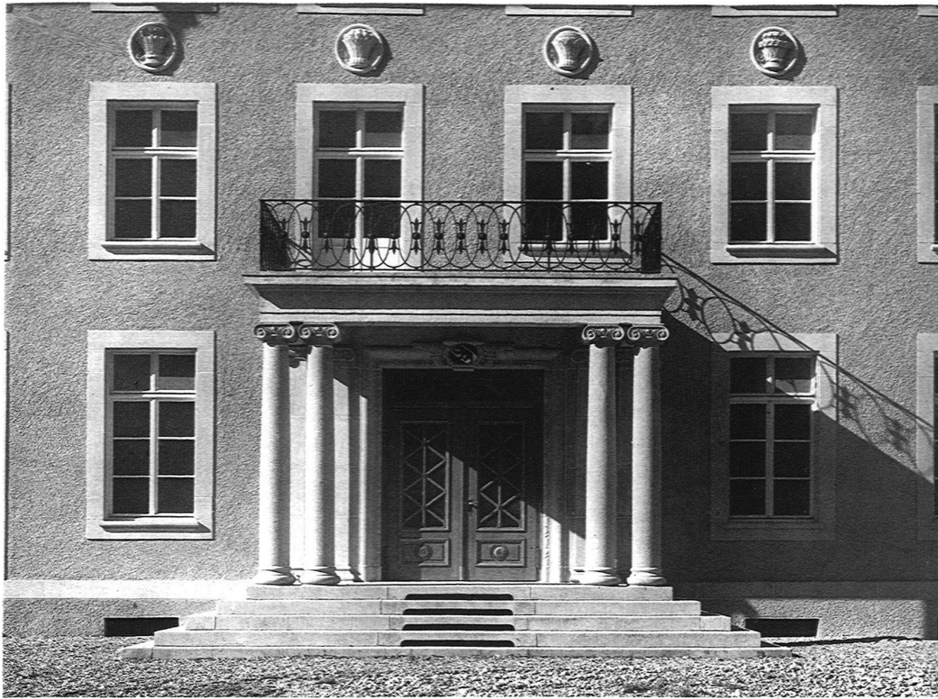
ABB. 10 LEHRGEBÄUDE HAUPTINGANG Phot. Henn
