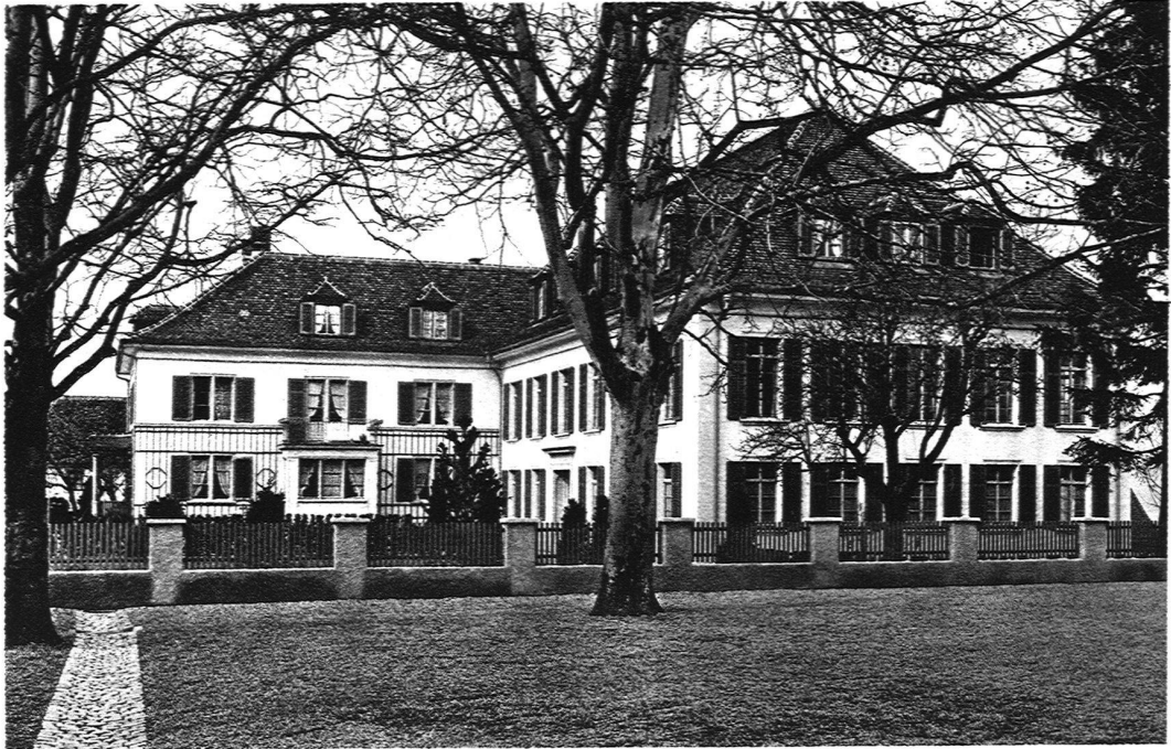
ABB. 14 KIRCHGEMEINDEHAUS UND PFARRHAUS IN ZÜRICH-WOLLISHOFEN GESAMTANSICHT Phot. E. Linck
