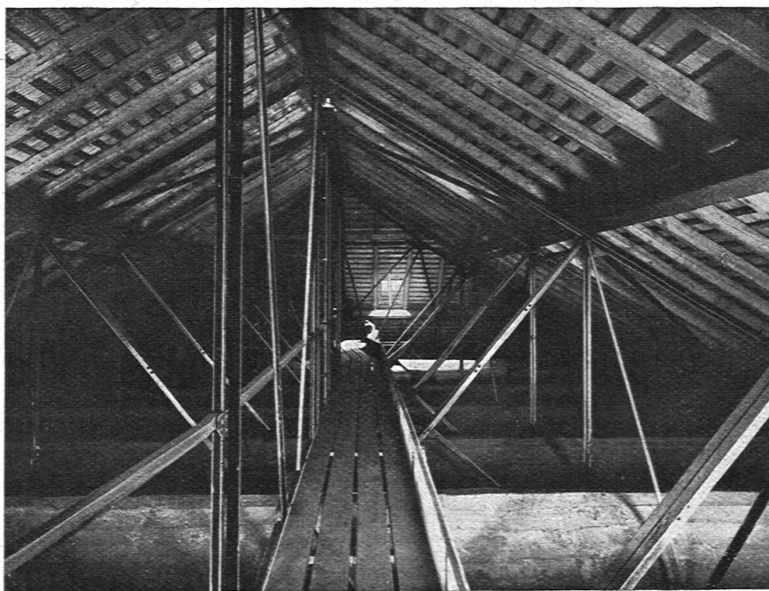
Abb. 3. Blick in den Dachraum über der Synagoge. (Ausführung der Eisenkonstruktion durch die Firma Löhle & Kern A. G., Zürich.)
