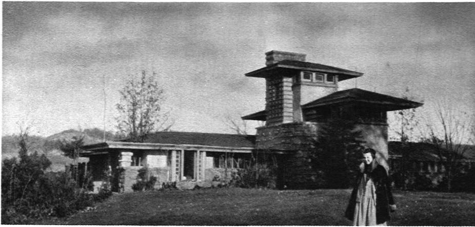
LANDHAUS WRIGHT Ansicht von Süden über den Wiesenplatz gegen Turm und Privatspeisezimmer
