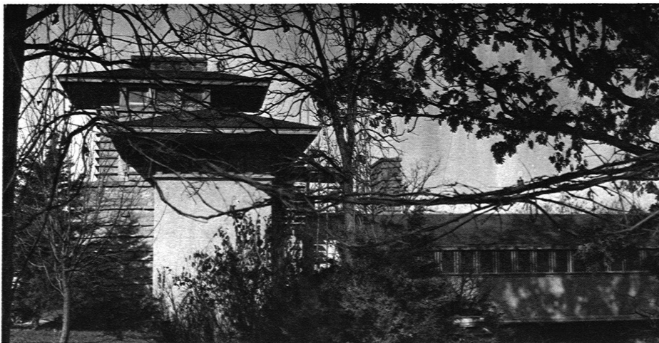
LANDHAUS WRIGHT Turm mit Galerie über der Durchfahrt
