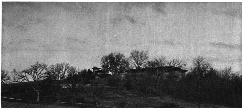
LANDHAUS F. L. WRIGHT BEI SPRING GREEN, WISCONSIN Gesamtansicht von Süden (Plan Seite 147)
