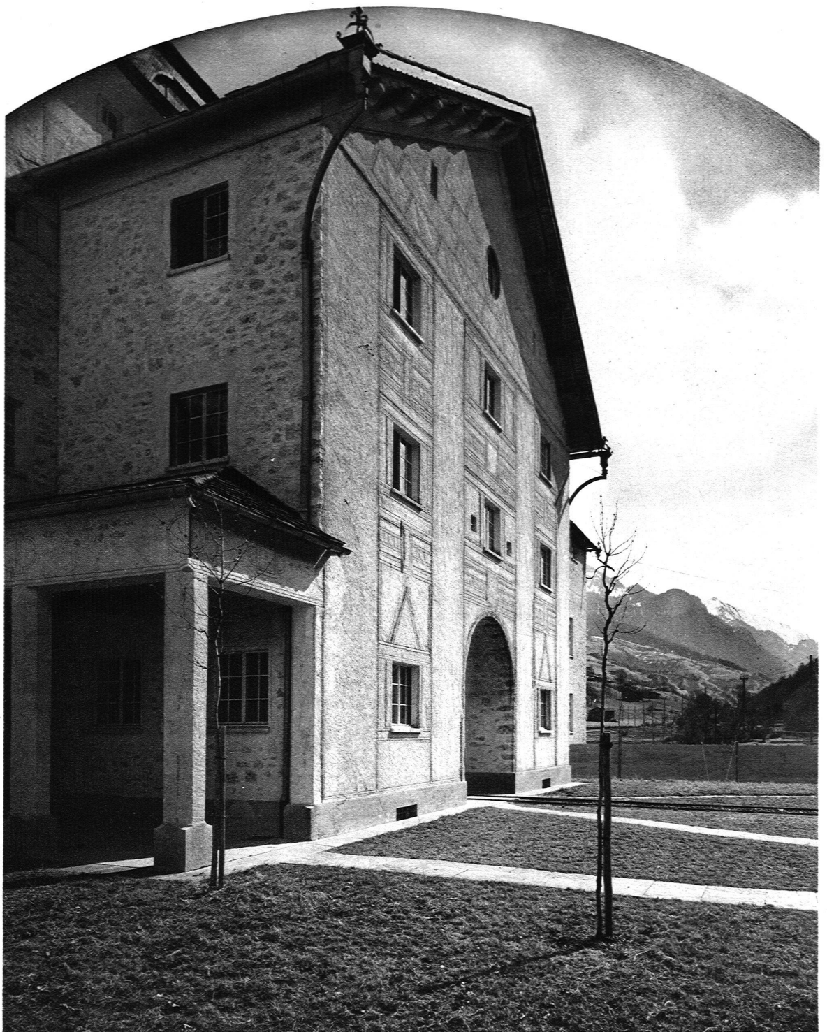
NICOL. HARTMANN & CIE., ARCHITEKT B.S.A. IN ST. MORITZ ZENTRALE KÜBLIS DER A.G. BÜNDNERKRAFTWERKE Kopf des Maschinenhauses / Phot. A. Steiner
