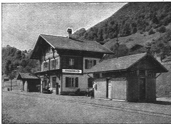
Station der Brienerseebahn
