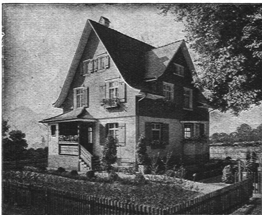
Abb. 6. In Eternit erstelltes Wohnhaus.
