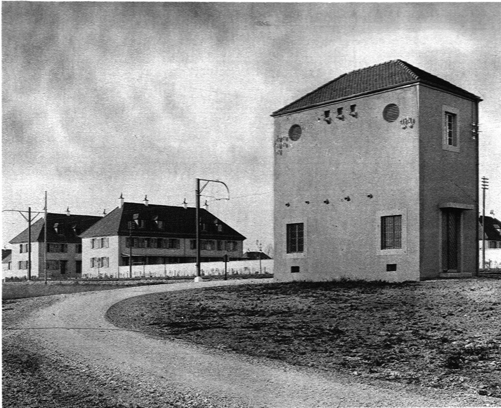
TRANSFORMATORENHAUS Phot. Hoffmann
