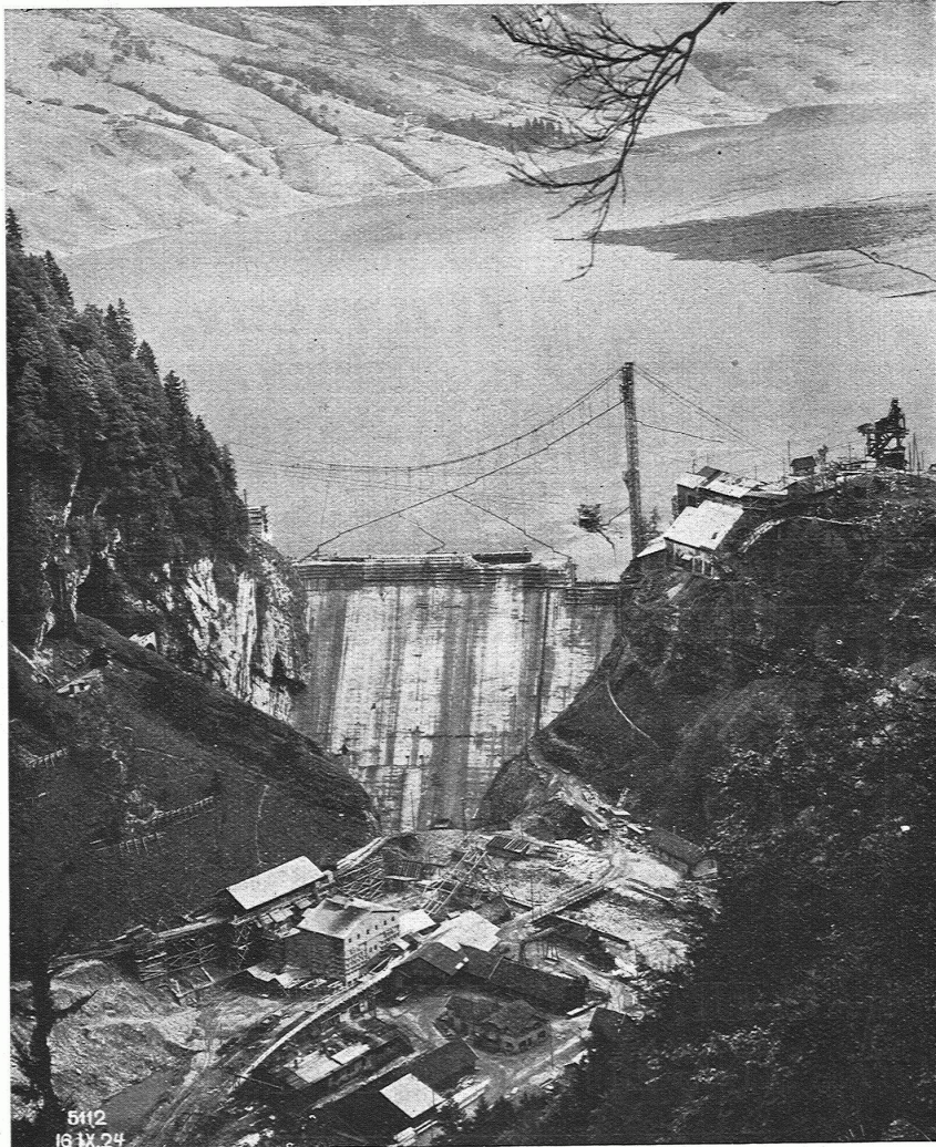
Staumauer im „Schräh“ Wäggital
