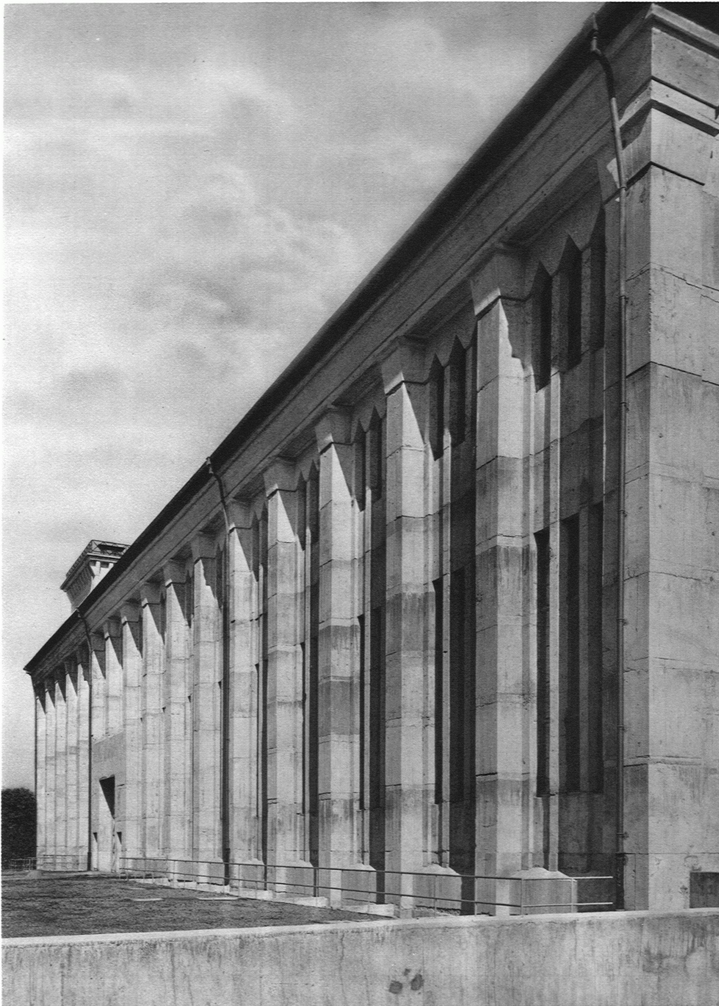
26. ZENTRALE SIEBENEN / ARCHITEKTEN GEBR. BRÄM B.S.A., ZÜRICH Seitenfront des Maschinenhauses
