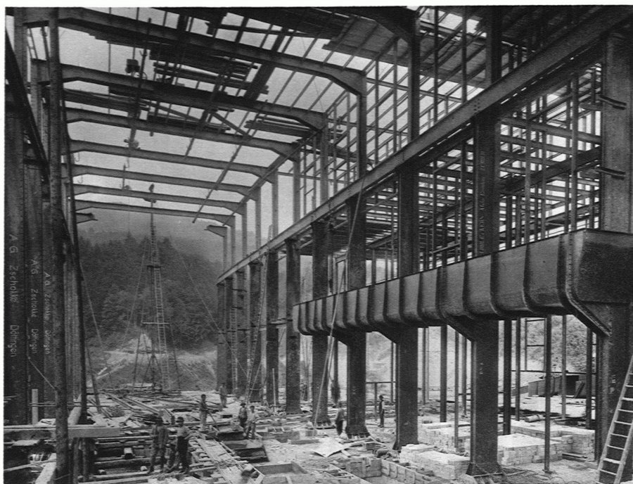
42. MASCHINENHAUS REMPEN / MONTAGE DES EISENHOCHBAUES
