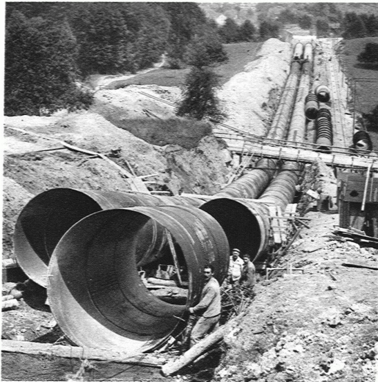
23. DRUCKLEITUNG SIEBNEN Verlegen der 2,50 m weiten Röhre in den Boden
