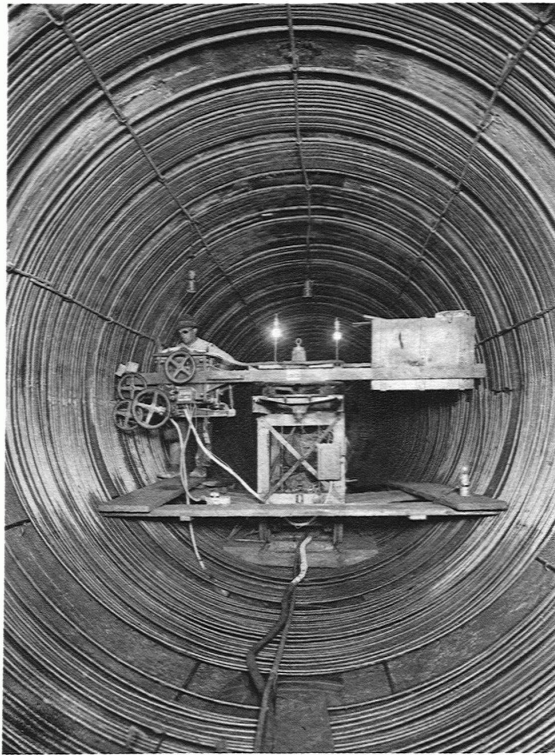
15. Die als halbe Ringe in den obern Druckstollen eingebrachten 22 Millimeter Rundeisenarmierung werden am Ort mittels spezialkonstruierter Stumpfschweissmaschine elektrisch verbunden
