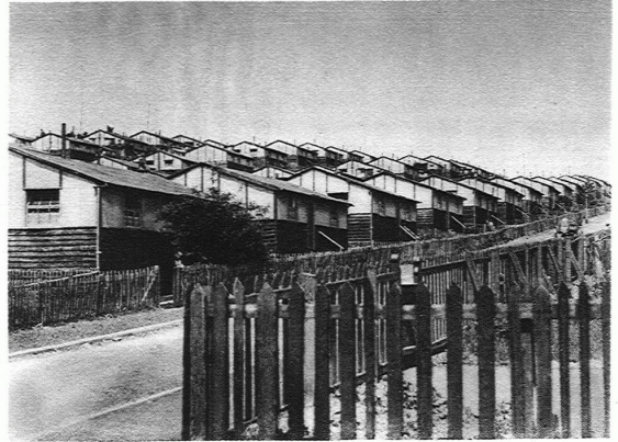
MUNITIONSARBEITER-SIEDELUNG WELL HALL ZU ELTHAM, KENT Building Departement Woolwich Arsenal / Grundriss siehe Seite 225 / Holzkonstruktion, Eternitwände, Teerpappdach
