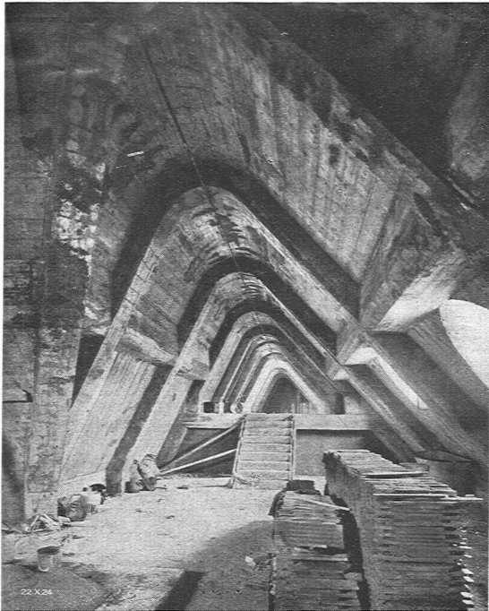
Abb. 6. Dachkonstruktion in armiertem Beton.
