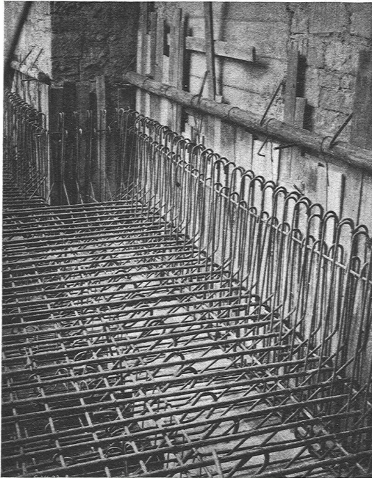
Abb. 3. Armierung der untern Fundamentplatte, Anschluss an die Brandmauer des St. Annahofes.
