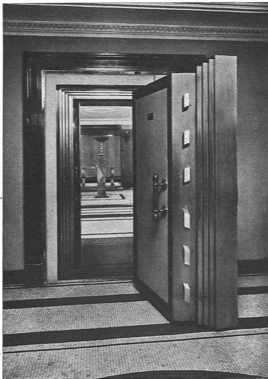
Abb. 2. Die Panzertüre zum Saferaum. Ausführung der Firma A. & R. Wiedemar, Bern.
