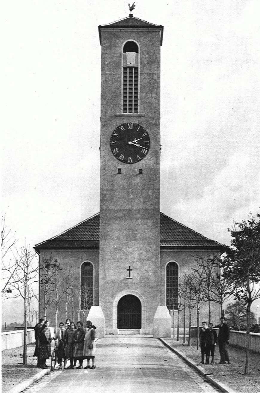
DIE NEUE KIRCHE DER REFORMIERTEN KIRCHGEMEINDE DIETIKON ERBAUT VON EMIL SCHÄFER, ARCHITEKT B.S.A., ZÜRICH, 1924/1925 Phot. Wolf-Bender, Zürich
