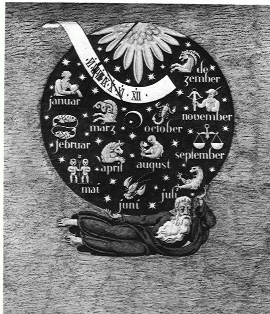
SONNENUHR AN DER RÜCKFASSADE Wandmalerei von Rudolf Mülli, Zürich Phot. Wolf-Bender
