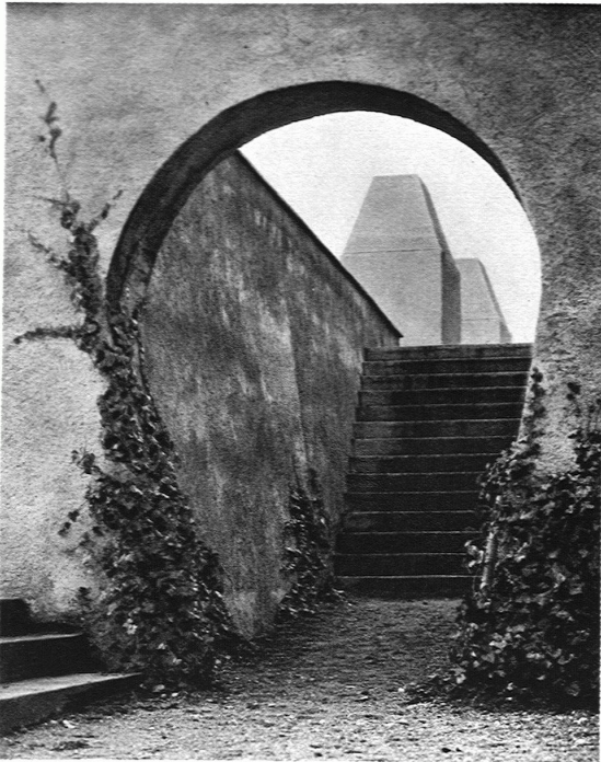
SEITLICHER TREPPENAUFANG Phot. Wolf-Bender
