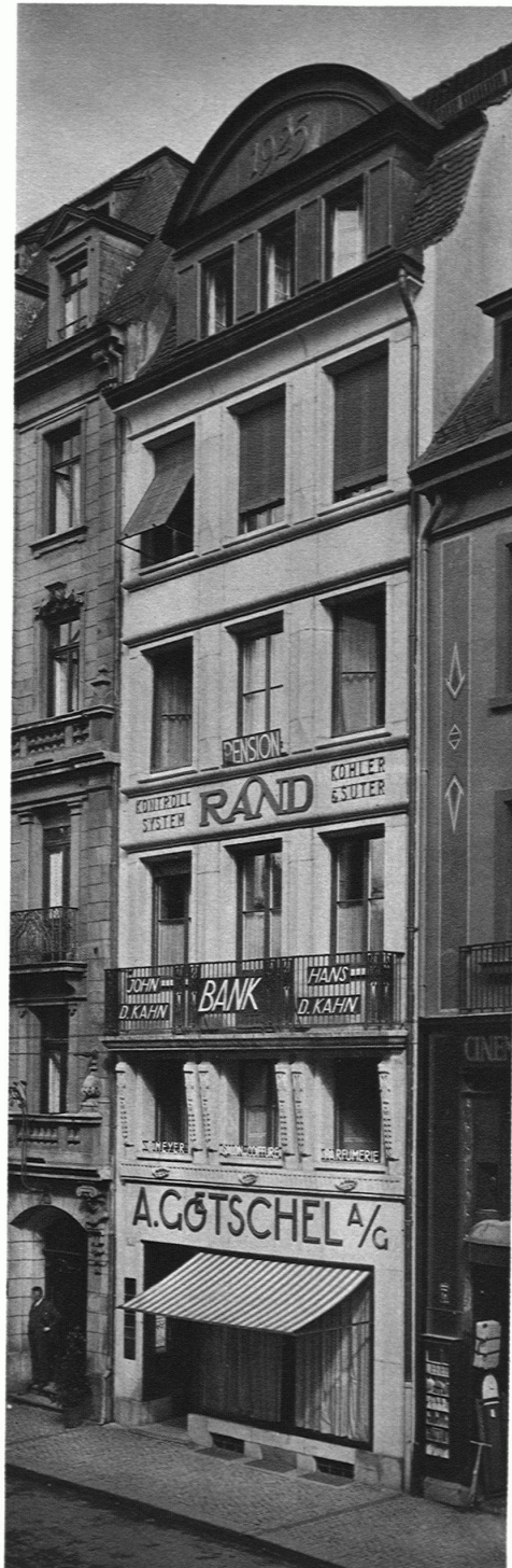
WOHN- UND GESCHÄFTSHAUS A. GOETSCHEL FASSADE Phot. Th. Hoffmann
