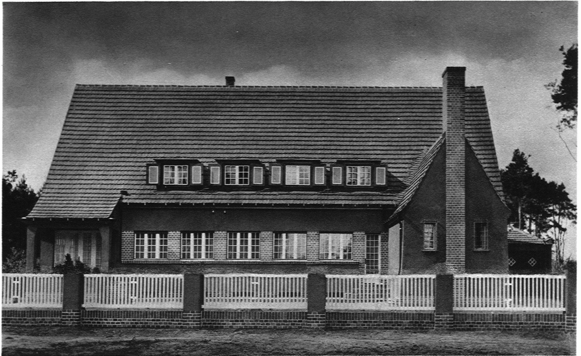
STEGER & EGENDER, ARCHITEKTEN B.S.A., ZÜRICH / LANDHAUS IN COTTBUS / SÜDSEITE
