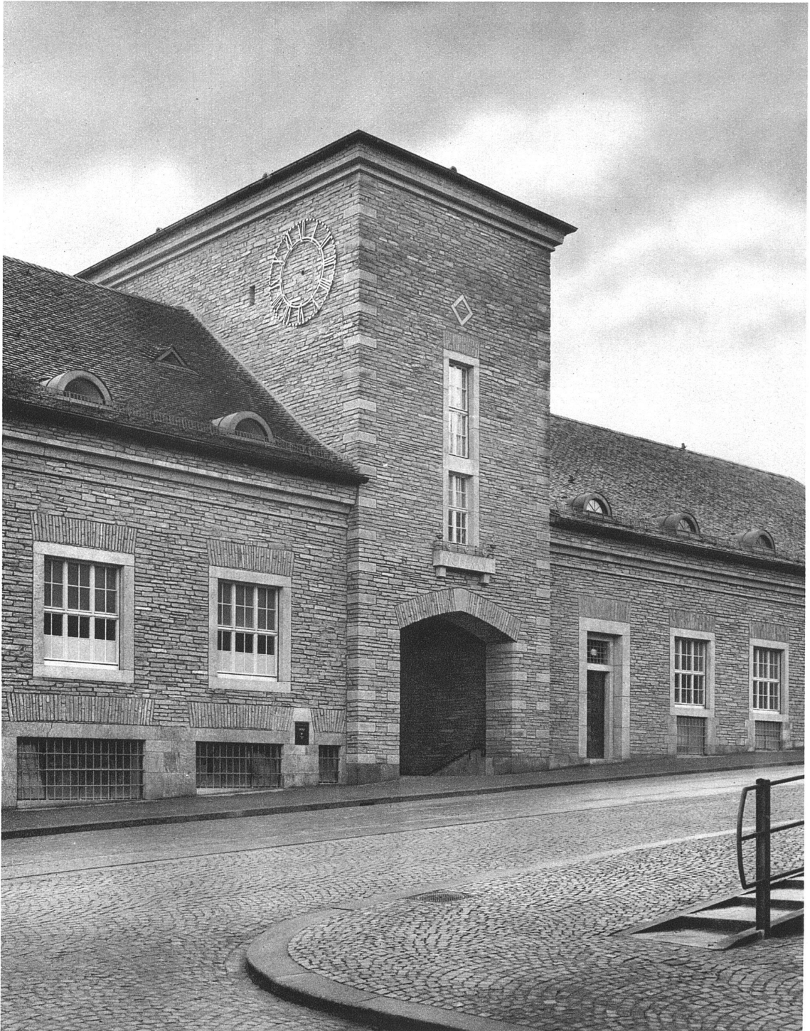
Eingang an der Bederstrasse
