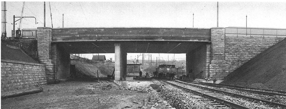
HOHLSTRASSENBRÜCKE von Süden gesehen
