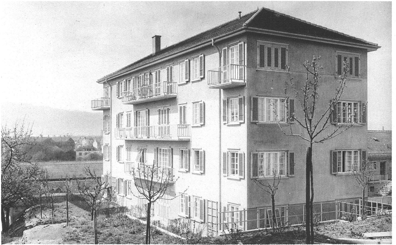
OBEN: BAU 2 / BAUGENOSSENSCHAFT FÜR BERUFSTÄTIGE FRAUEN RECHTS: BAU 1 / BAUGENOSSENSCHAFT LETTENHOF
