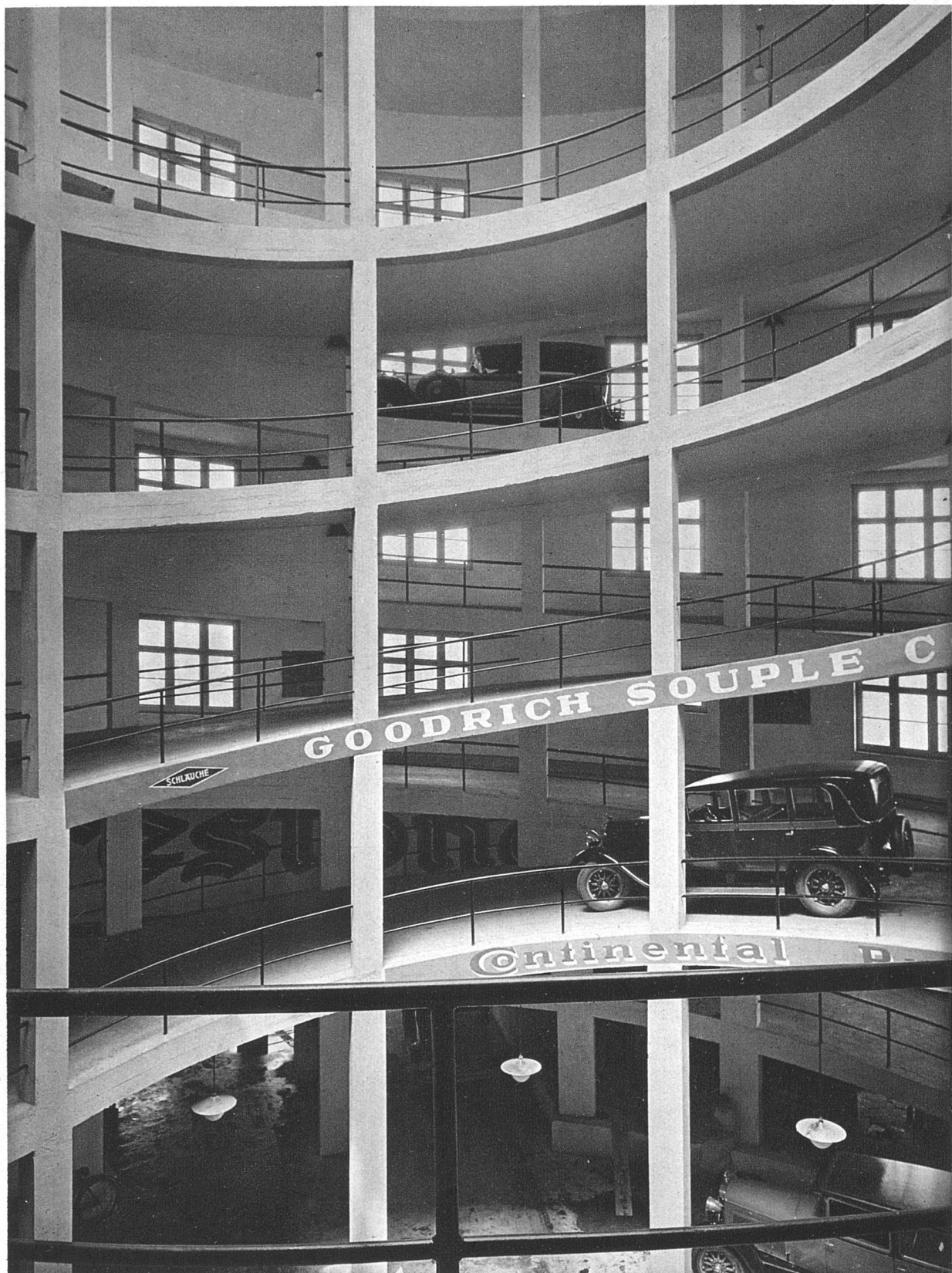
GARAGE C. SCHLOTTERBECK, BASEL / RAMPENTURM
