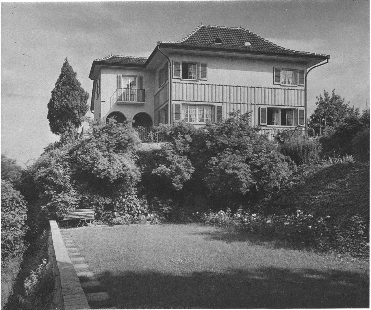
ANSICHT VON DER TIEFLIEGENDEN TERRASSE AUS
