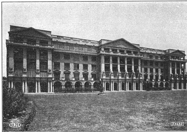
Country Hospital in Shanghai, ausgerüstet mit Sulzer-Ventilationsanlage.
