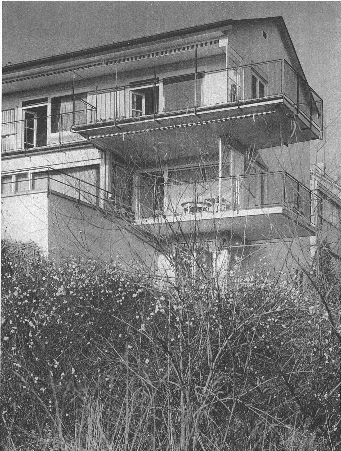
ARZTHAUS AN DER RENGGERSTRASSE, ZÜRICH ANSICHT VON SÜDOSTEN ARCH. MAX ERNST HAEFELI, ZÜRICH
