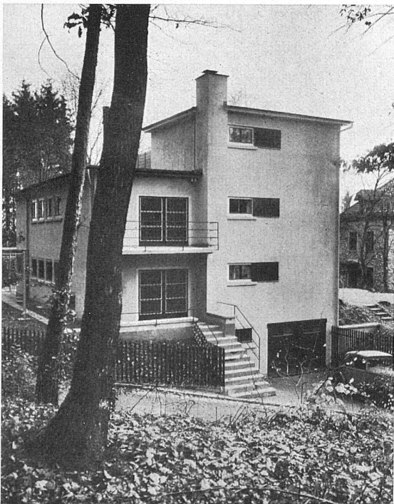
NORD- UND NORDWESTANSICHT VON DER KLUSSTRASSE
