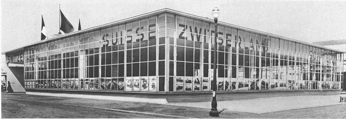
Südostecke und Umgebung des Pavillons unten: Nordostecke
