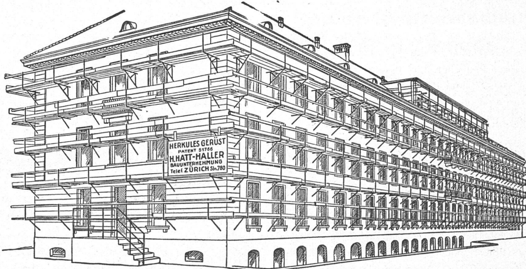
Dermatologische Klinik Zürich, eingerüstet mit
