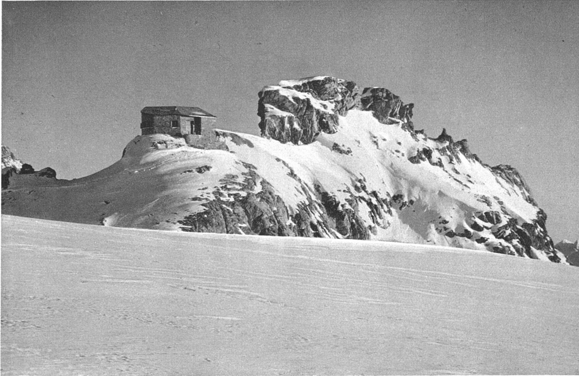
Ansicht von Nordwesten Planurahütte der Sektion Tödi S. A. C. Architekt Hans Leuzinger B. S. A., Glarus Höhe 2920 m über Meer Erbaut 1930
