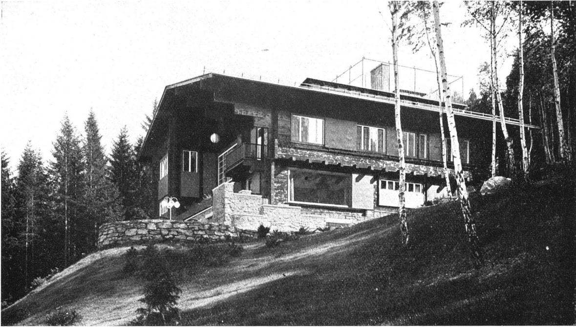
ADOLF LOOS, WIEN Landhaus K. in Payerbach bei Wien (900 m hoch, Semmeringgebiet) 1930 Blockbau über Bruchsteinsockel, Dach mit Blech gedeckt, eiserne Schiebläden in Schienen
