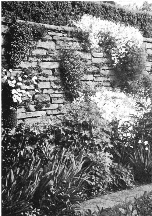
Vegetation in und vor der grossen Stützmauer
