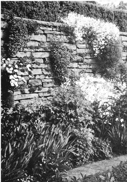
Vegetation in und vor der grossen Stützmauer
