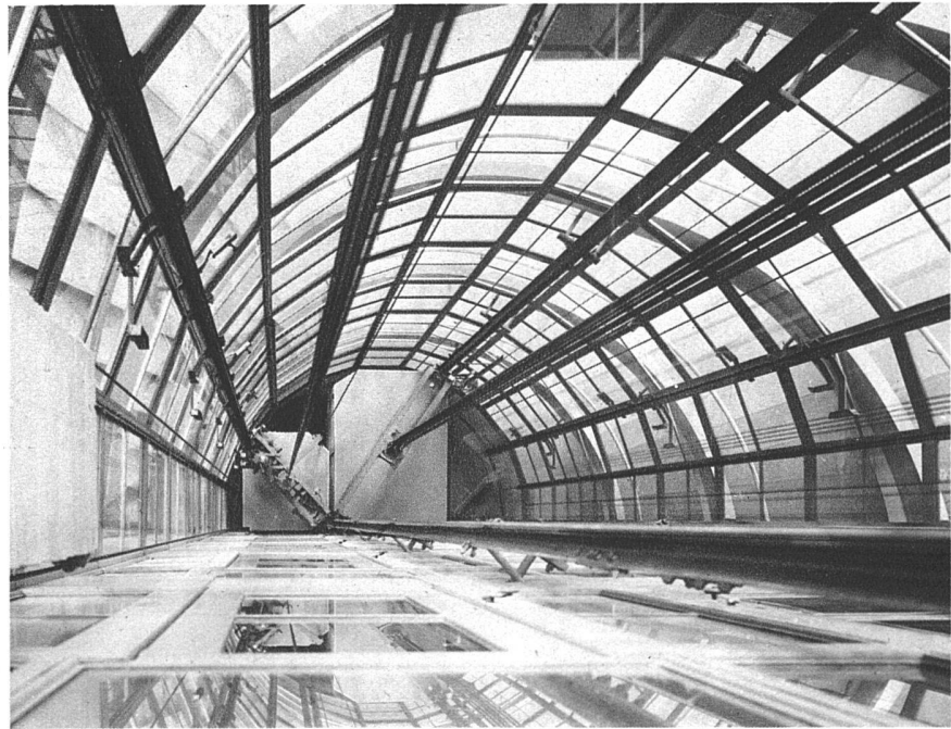
Glasdach über den Nebenräumen des grossen Börsensaales
