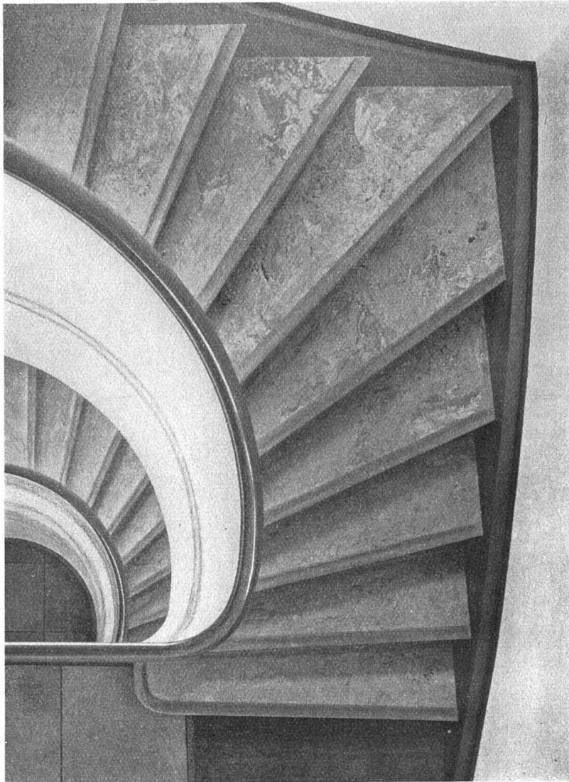
Treppe mit Gummibelag und Gummikanten in einer Privatvilla
