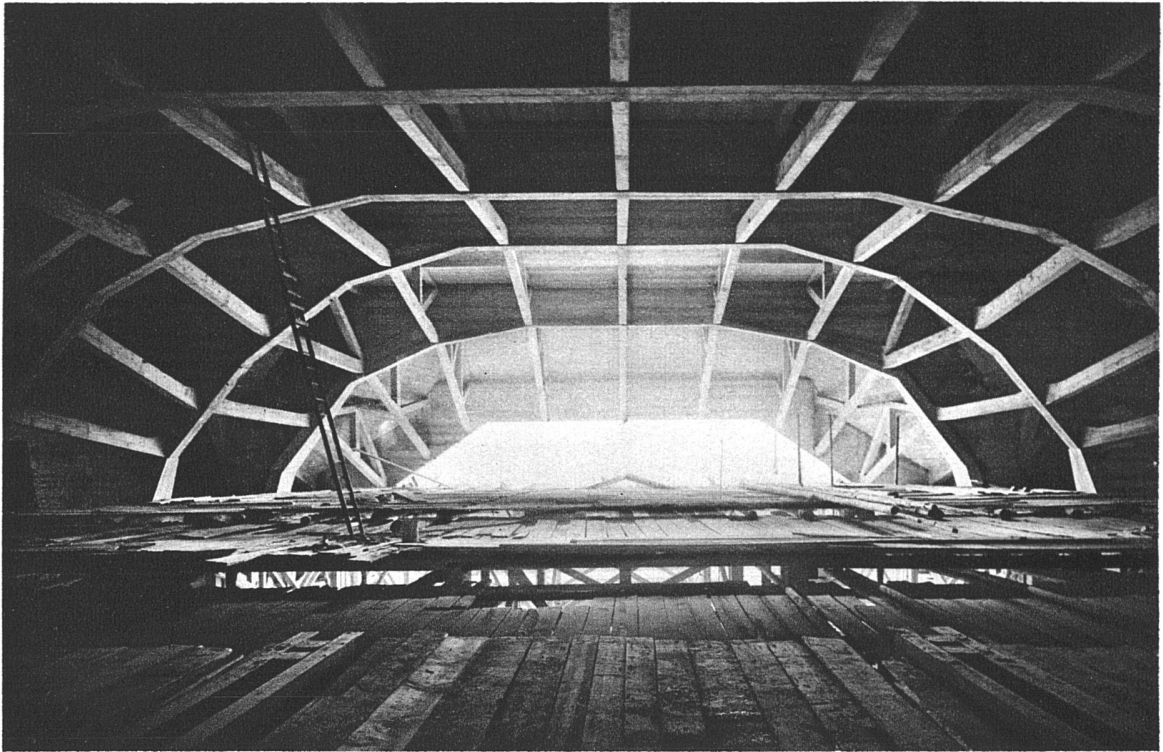
Dornach, neues Goetheanum, grosser Saal. Blick vom Lehrgerüst in Kämpferhöhe gegen Westen. Der westliche Treppenhausvorbau fehlt noch. Ersichtlich sind die fünf grossen Saalrahmenbilder, an denen später das auf dem unteren Bild sichtbare Rabitzgewölbe aufgehängt wurde. Unten: Grosser Zuschauerraum und Vortragssaal. Blick gegen die Bühne, davor versenkbares Rednerpult. Links und rechts unten Seiteneingänge, der Haupteingang rückwärts in der Achse des Saales. Sämtliche Wände und Decken sollen später künstlerisch ausgestaltet werden
