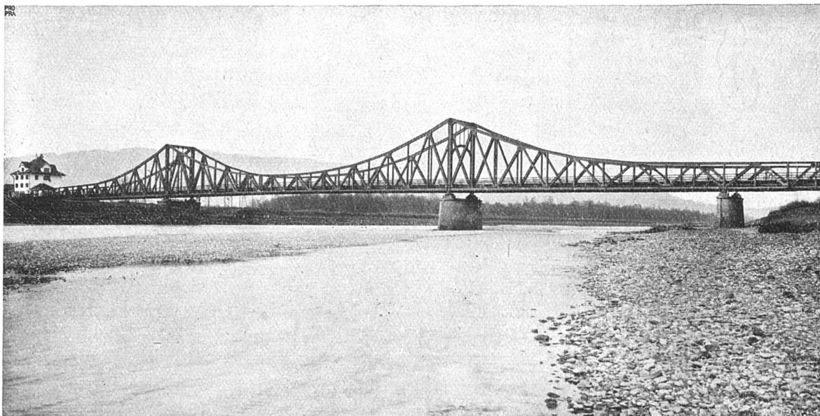
Strom-Brücke aus Stahl für schweren Verkehr. Wirkt durch die Eleganz der Linienführung. Grosse Spannweiten — 93 Meter! Wenig Pfeiler. Beim Bau minimale Versperrung des Flusses durch Gerüst-Einbauten. Vorteilhafte Anpassung an die Umgebung. Auskunft über den Stahlbau erteilt
