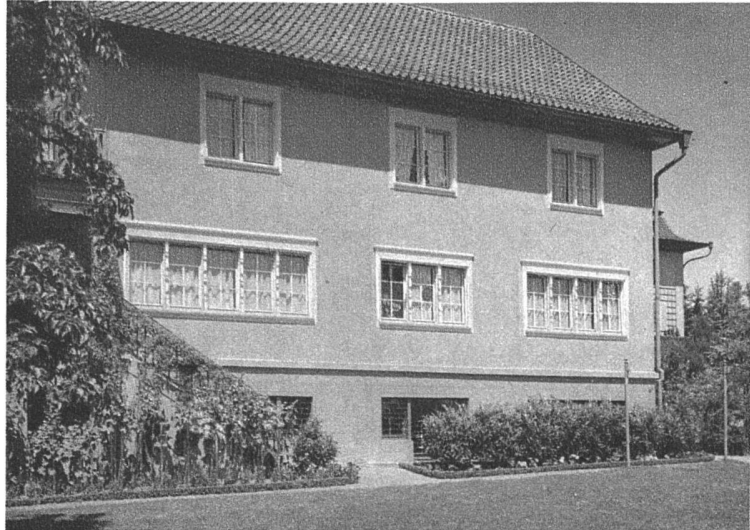
Wohnhaus an der Goethestrasse, St. Gallen Architekt Ernst Kuhn BSA, St. Gallen
