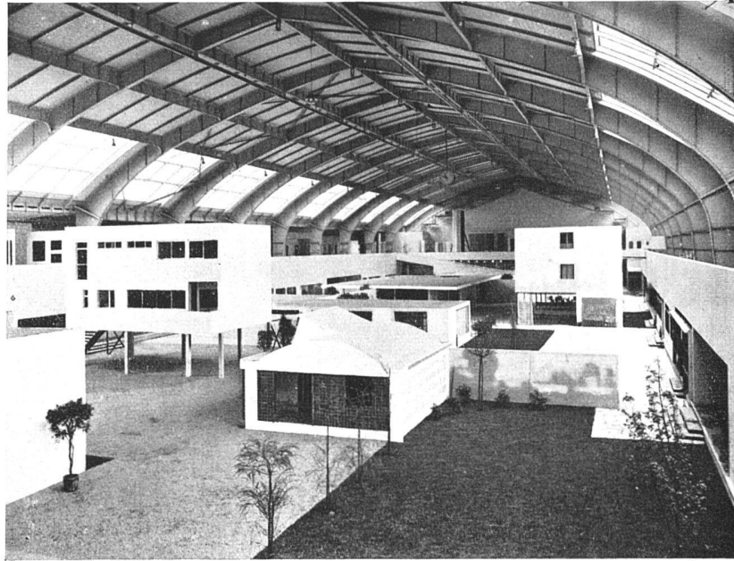
links: Haus Haesler, rechts davon: eingeschossiges Reihenhaushaus von H. Haering, Berlin, mit Fenstern nach O und W und besonderer sheddachartiger Dachgaube für die Südsonne; rechts hinten: das Bordinghaus von Vorhoelzer, Wiederanders und Schmidt
