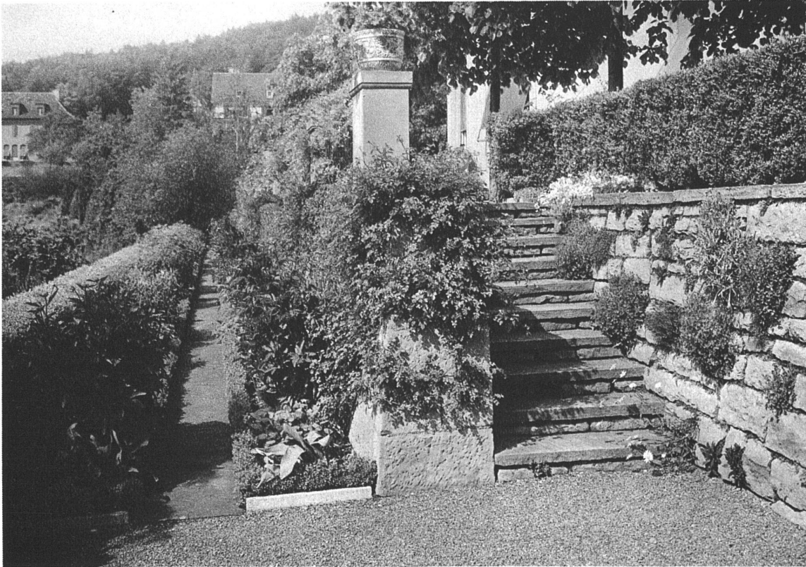
Trockenmauer und Treppe zum Wohnhaus
