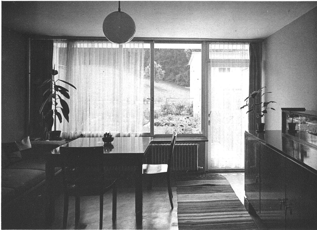
Wohnzimmer Holzschiebefenster mit ungeschliffenem Spiegelglas («Similiglas»)
