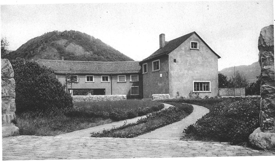
Ansicht von Nordwesten Einfahrt, rechts Wohn-, links Wirtschaftsflügel
