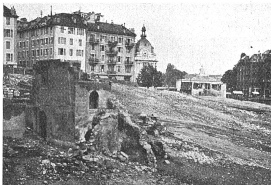
Fin des démolitions du Quai du Seujet, Genève
