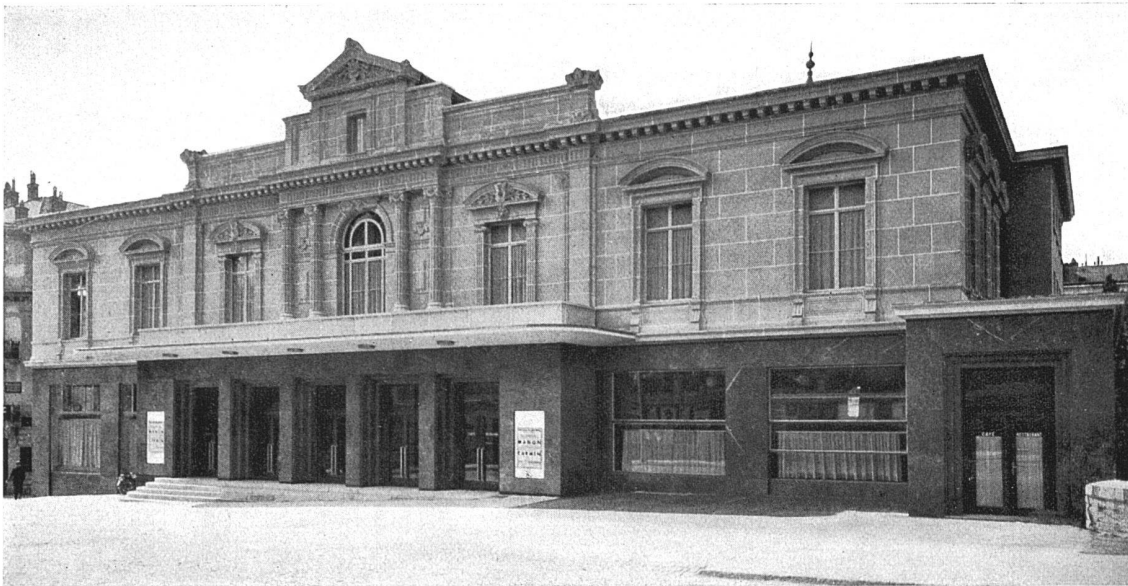
Théâtre municipal de Lausanne Entrée principale de l'avenue de la Gare, ancienne façade renovée Die bestehende Fassade wurde im Erdgeschoss mit Marmorplatten verkleidet
