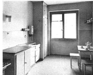
Jedes Haus bildet für sich einen Bauteil. An jeder Treppe mit Lift sind pro Stockwerk 2 Drei- oder Zweizimmerwohnungen untergebracht. Die Küchen und Badzimmer haben Warmwasser aus Gasboilern. Aussenmauern und tragende Wände im Innern aus Backstein. Hohlkörperdecken mit Inlaidbelag auf Isolationsunterlage. In Küchen und Badzimmer Boden- u. Wandplättli. Mietzinse für 2- und 4-Zimmerlogis von Fr. 1400.- bis Fr. 2450.-.
