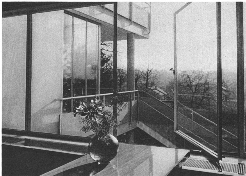
Fensterflügel abwechselnd fest oder drehbar, mit exzentrisch angeordneten Drehzapfen, so dass die geöffneten Flügel nicht zu weit ins Zimmer vorstehen
