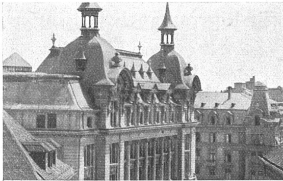
Hauptpostgebäude Bern vor dem Umbau. Der auf diesem Bild nicht sichtbare Hauptturm wird erst in der nächsten Bauetappe abgetragen werden
