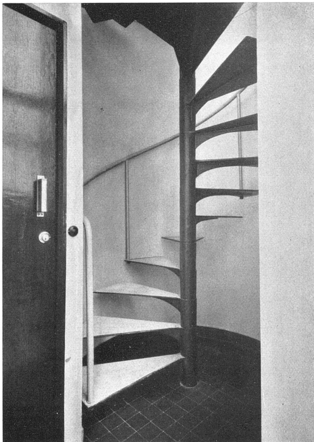
Escalier intérieur d'un appartement à deux étages, en pièces détachées de fonte de fer Verbindungstreppe im Inneren einer der zweigeschossigen Mietwohnungen, aus einzelnen Gusseisenelementen zusammengesetzt
