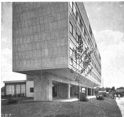
Westliche Schmalseite mit dem offenen Erdgeschoss
